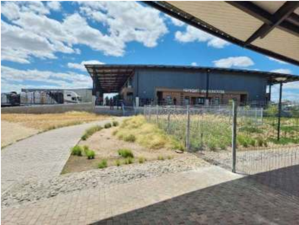
Beitbridge border post warehouse
